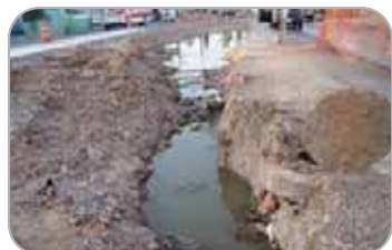
Tareas en el alcantarillado público
