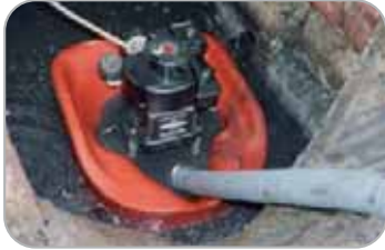
Extracción de agua desde pozos
