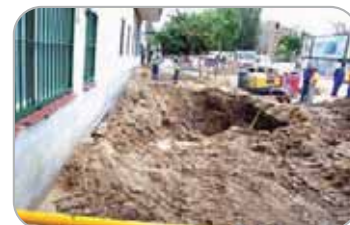
Trabajos de perforación y obra pública
