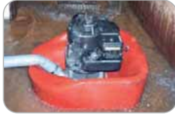
Inundaciones en bajos y garajes
